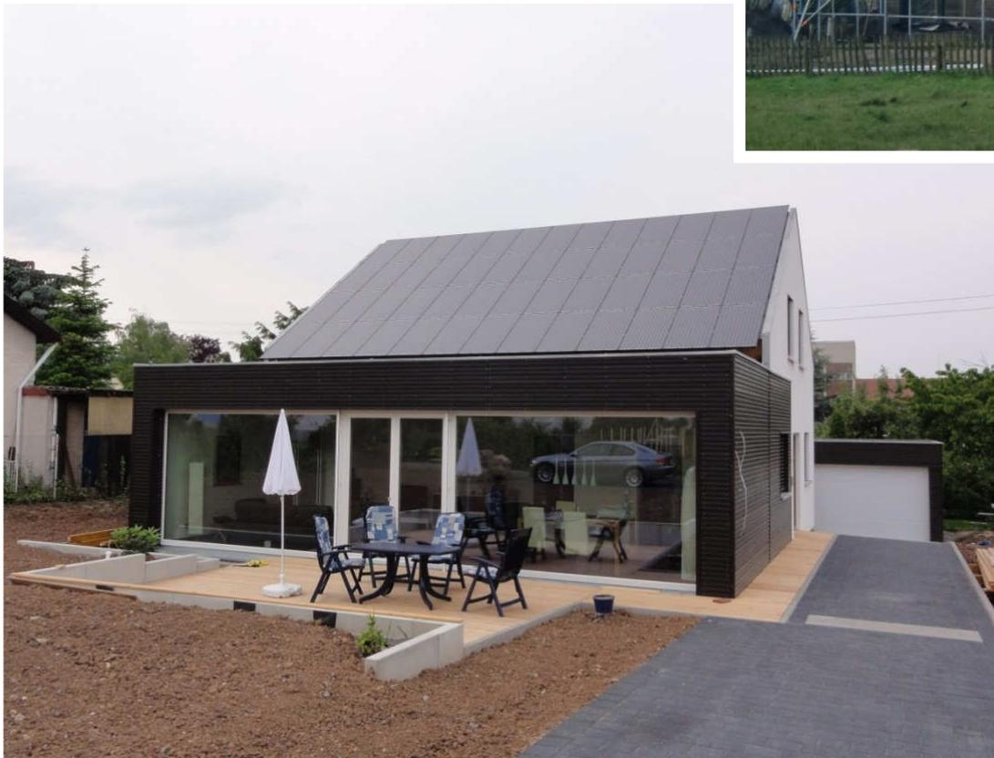
Eine Photovoltaikanlage auf dem Dach erzeugt im Jahr mehr Energie als für Heizung, Warmwasser und Haushalt benötigt wird.
